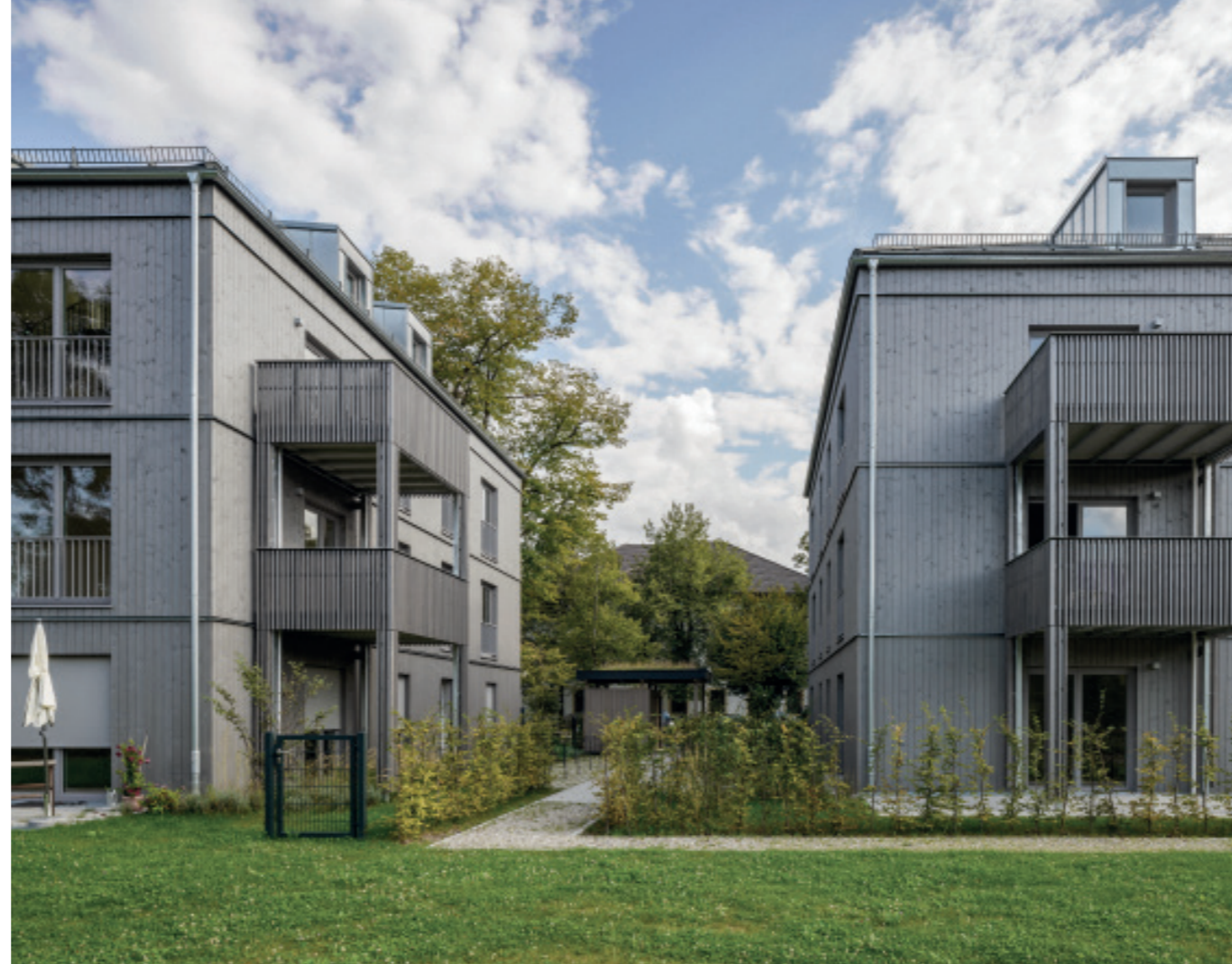
Alle Wohnungen erhielten großzügige Freibereiche in Form von vorgestellten Balkonen sowie Terrassen im Erdgeschoß. Die Fassade wurde mit einer geschoßweise getrennten, vertikalen Holzverkleidung aus einer grau beschichteten Fichtenschalung versehen.
