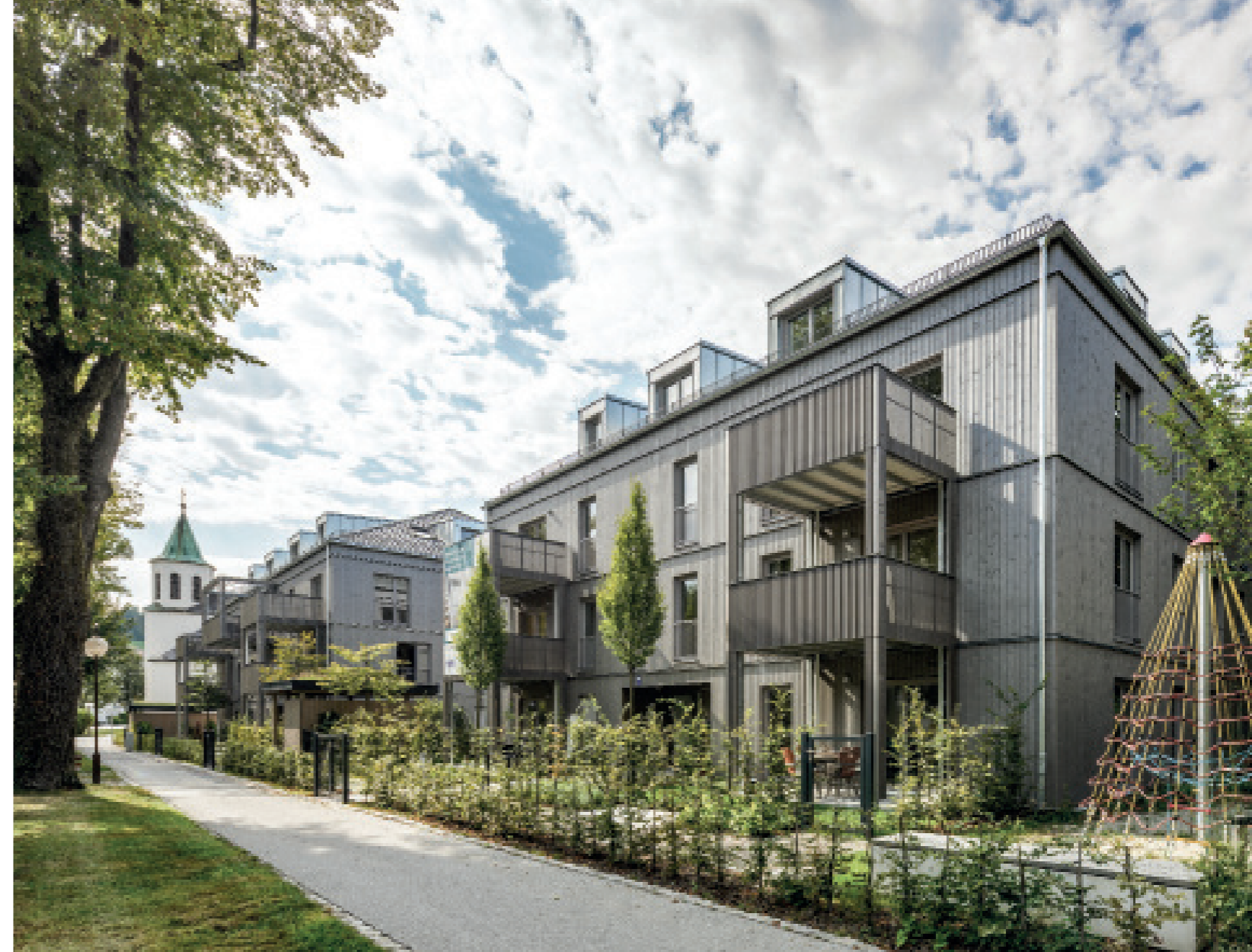
In den beiden Gebäuden wurden rund 650 m³ Holz verbaut. Die Konstruktion speichert dadurch dauerhaft 524 t CO 2 -Emissionen. Für den Bau wurde ausschließlich PEFC-zertifiziertes Holz verwendet.
